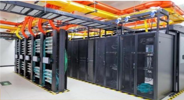
理大的数据中心使用了6500个端口的勒克超六类铝箔屏蔽布线和约10000个OM 4端口
